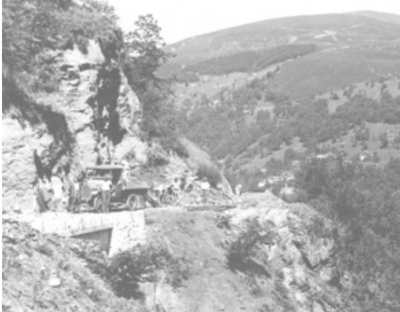
Costruzione della strada in Val Colla (ca. 1935-1945). Proprietà Aquilino Antonini
